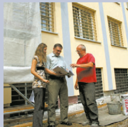
I. Adamczak-Garstecka wraz z inspektorem nadzoru M. Kaniewskim
